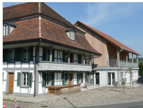
Arbeitsräume und Verwaltung in Bleienbach
