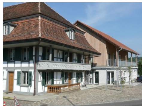
Arbeitsräume und Verwaltung in Bleienbach
